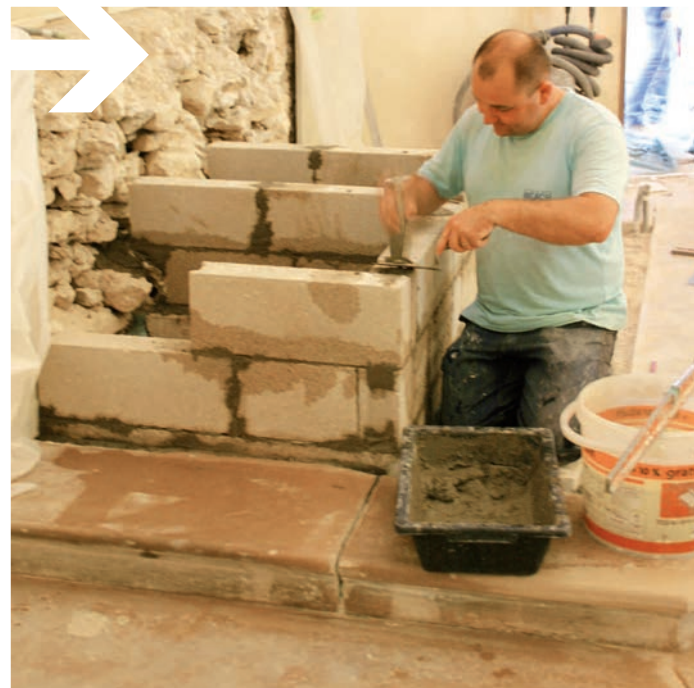
Réalisation du socle du maître-autel.
