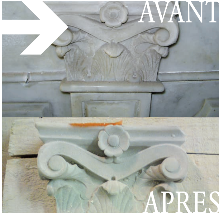
Bas-relief du maître-autel avant et après sa restauration.
