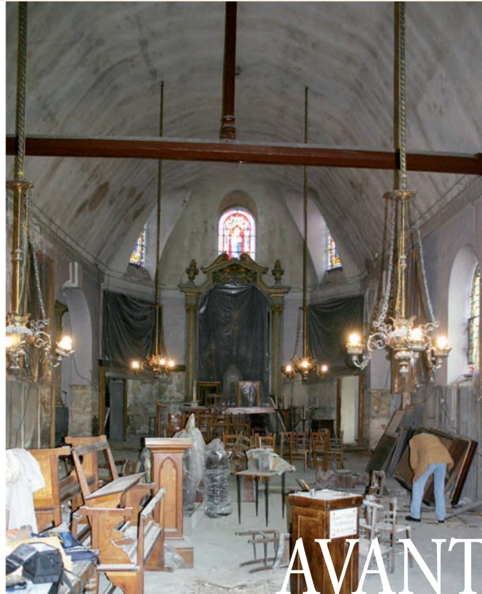
Intérieur de l'église avant les travaux – septembre 2007.
