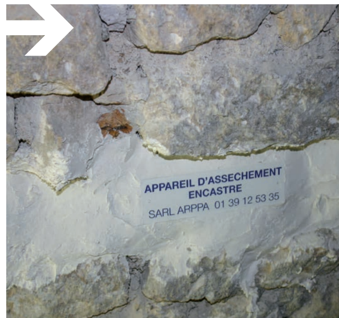
Janvier 2009 : Pose du système Murtronic pour lutter contre l'humidité.
