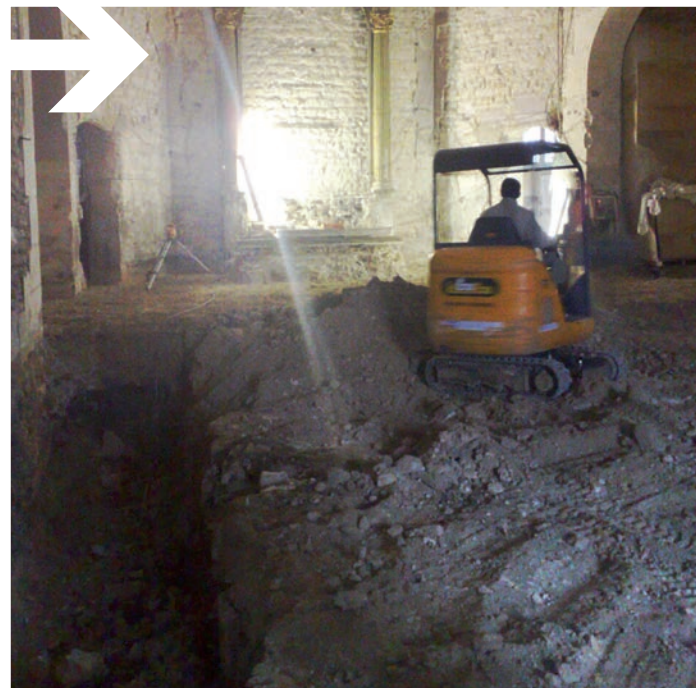
Février 2009 : Décaissement du sol pour l'isolation.
