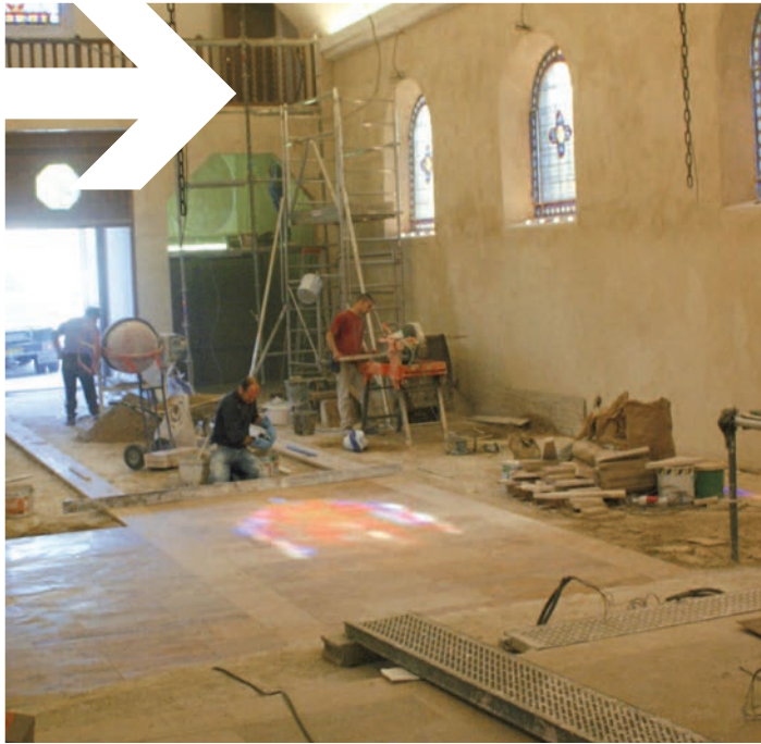
Mars 2009 : Pose des dalles en pierre beaunotte.
