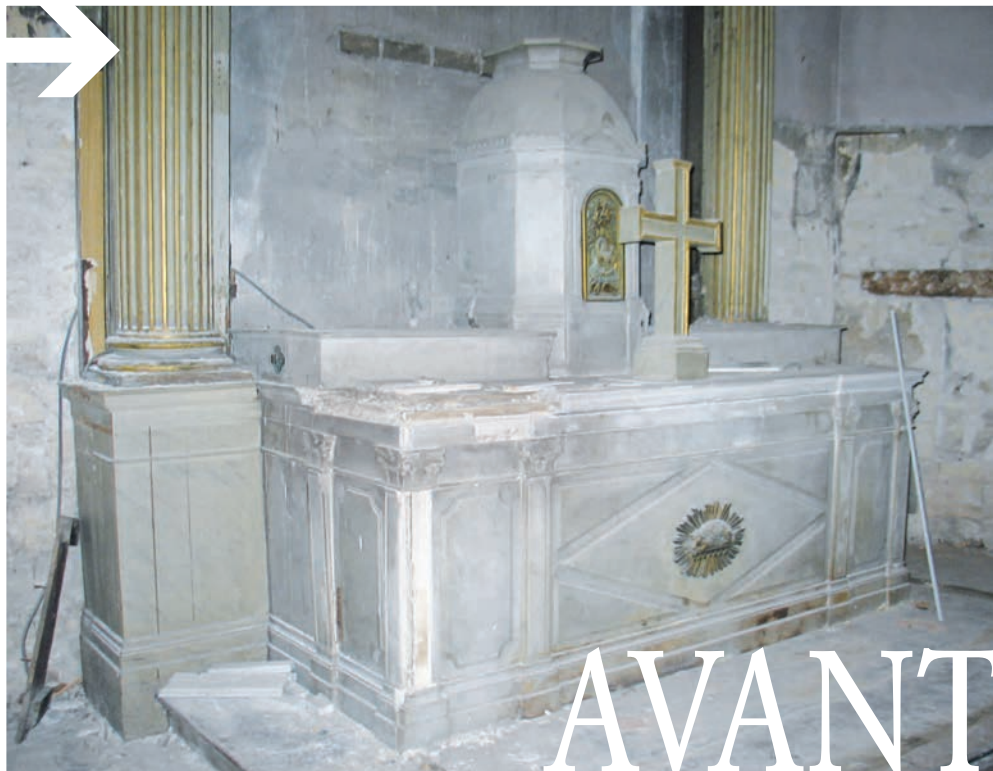
Maître-autel avant sa restauration
