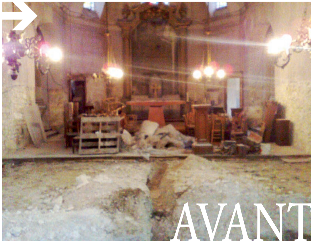
Septembre 2008 : tranchée dans les sols à la recherche de la source possible d'humidité.
