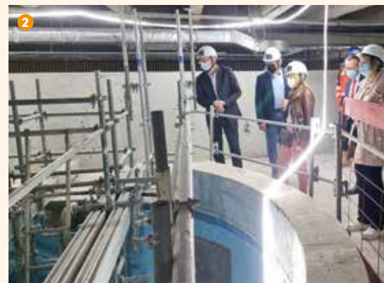
Le Maire, Igor Semo, visite le chantier de la piscine.
