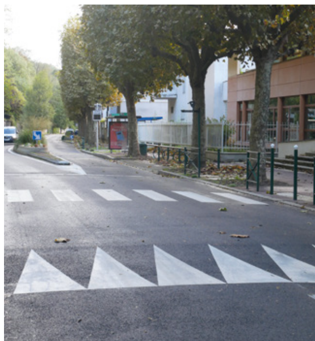
Réalisation d'un plateau surélevé devant le Centre de Formation par l'Apprentissage
