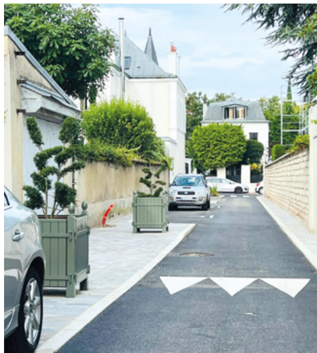
Rénovation de la voirie de la rue Jules Béclard
