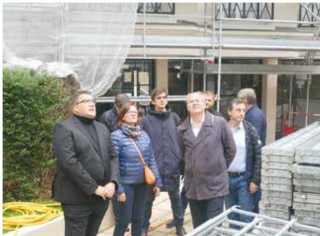
Le Maire, Igor Semo, s'est rendu sur place mi-octobre pour une visite de fin de chantier.
