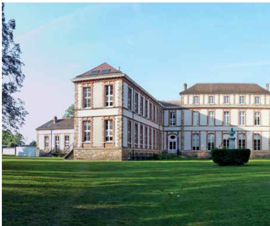
Château de Vacassy : actuellement le siège de l'agence nationale de Santé publique France. Construit en 1889 par l'architecte Trouillet suite au don du banquier Jean-Joseph Vacassy afin de créer un asile pour les convalescents.
